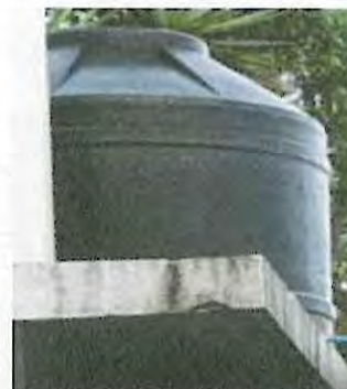
Foto 4: Deposito de agua
